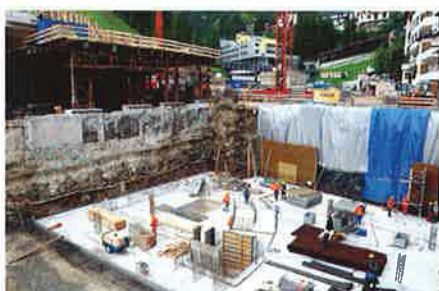
In nur acht Wochen wurde die Baugrube fertiggestellt.
