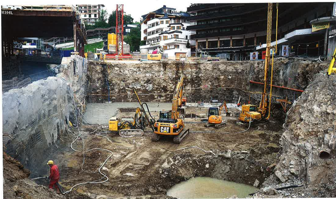
Als Gründungselement für den Infrastrukturtrakt wurden DS-Gründungskörper hergestellt.
