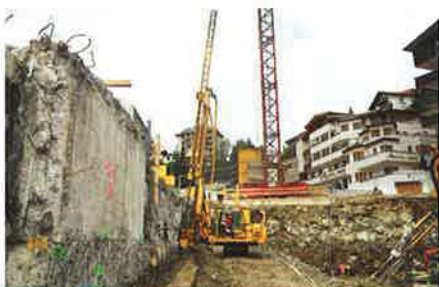
Gemischtkörniger Untergrund und eingebettete Steine erschwerten die Bauarbeiten.
